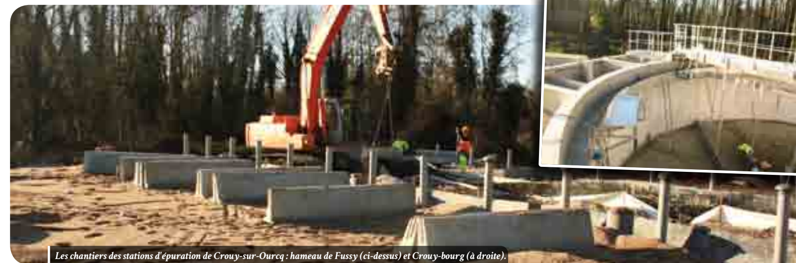
Les chantiers des stations d'épuration de Crouy-sur-Ourcq : hameau de Fussy (ci-dessus) et Crouy-bourg (à droite).
